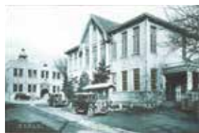
大正8年(1919)に完成した町役場は、ドイツルネサンス式の建物でした。奥に見えなのは警察署です。
