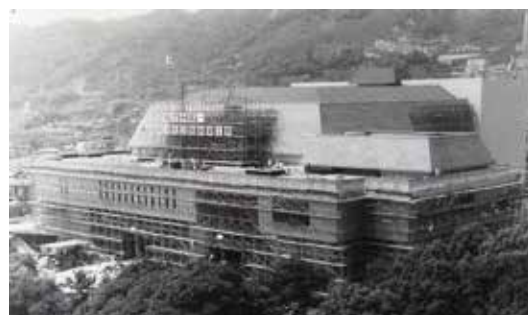
⑦建設中の文化会館
