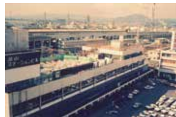
1975年、山陽新幹線が開通した頃の徳山駅
